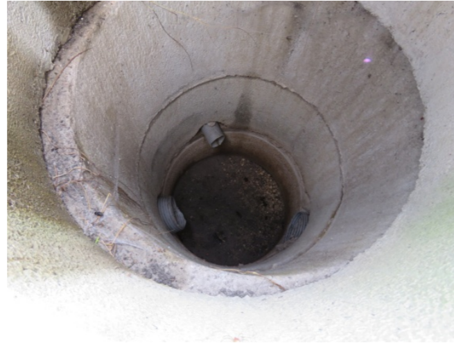
Intérieur du puits (à sec)
